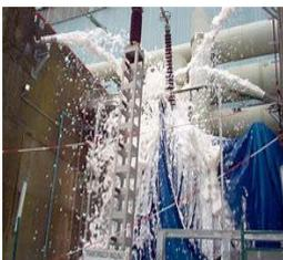
En estos sistemas, que son fijos, existe una corriente de agua que pasa a través de los diversos equipos, mezclándose con espumógeno, que es la sustancia que genera la espuma. Esta combinación se suele mezclar posteriormente con aire. Funcionan, en caso de incendio, arrojando una gran abundancia de espuma en la zona del incendio, la cual queda protegida en unos pocos minutos.
