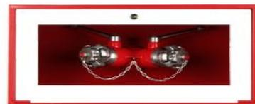
Es una instalación en edificios en altura para uso exclusivo de los bomberos con el objetivo de transportar el agua por todo el edificio.
