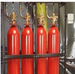
Estos sistemas extinguen el fuego usando gases naturales inertes. Se utilizan mucho en lugares en los que es imprescindible que los incendios se extingan de manera muy rápida, así como en aquellas zonas en las que es de vital importancia la prevención de los daños que podrían provocar los residuos u otros elementos.
