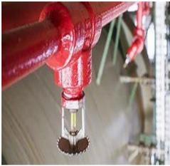
Son sistemas que se componen de rociadores distribuidos según sea la superficie a proteger. Estos rociadores, si se alcanza una temperatura en concreto, se abren, soltando agua. Si el incendio se produce en sólo una zona, únicamente se activarán los rociadores comprendidos en ella. En el momento en el que el fuego está extinguido totalmente, se cambian los rociadores por otros nuevos, quedando así el sistema a punto para que pueda ser usado otra vez.
