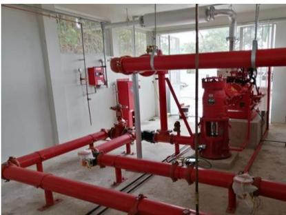
Es un sistema compuesto por una bomba y acoplado a un motor de combustión interna o eléctrico que será la fuente de supresión de fuego en caso de un incendio utilizando el agua como medio.
