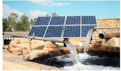
Consiste en una bomba hidráulica alimentada de manera directa por paneles solares fotovoltaicos, en lugar de ser abastecida mediante electricidad convencional o diésel.
