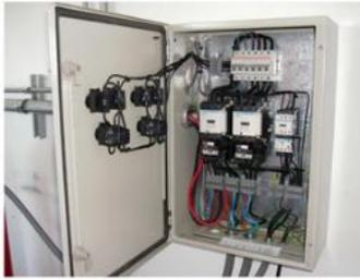
Cuadro de control para el arranque directo de dos bombas de agua de hasta 4Kw trifásicas con alternancia, preparado para ser controladas con boyas.
